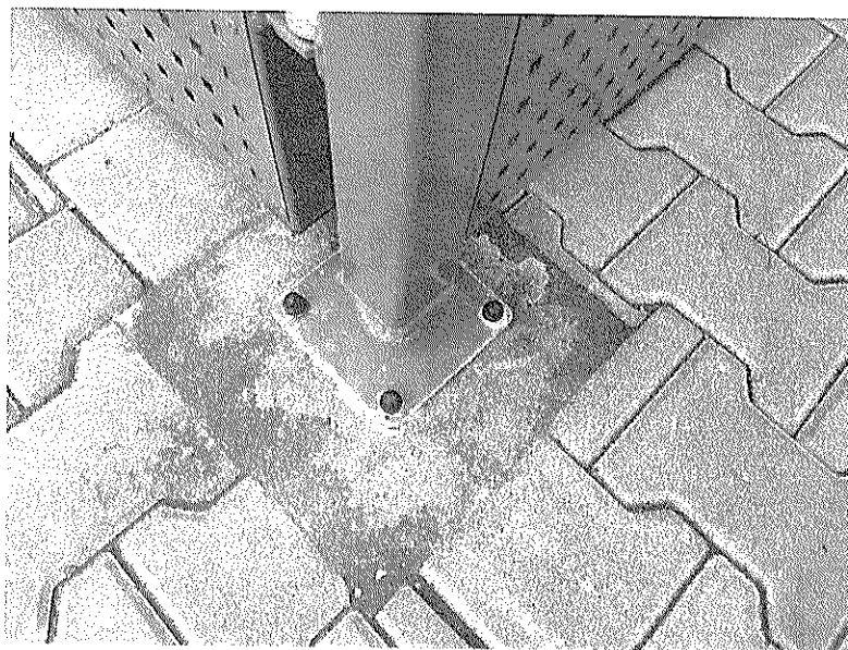
Mocowanie wiaty do prefabrykowanych fundamentów
