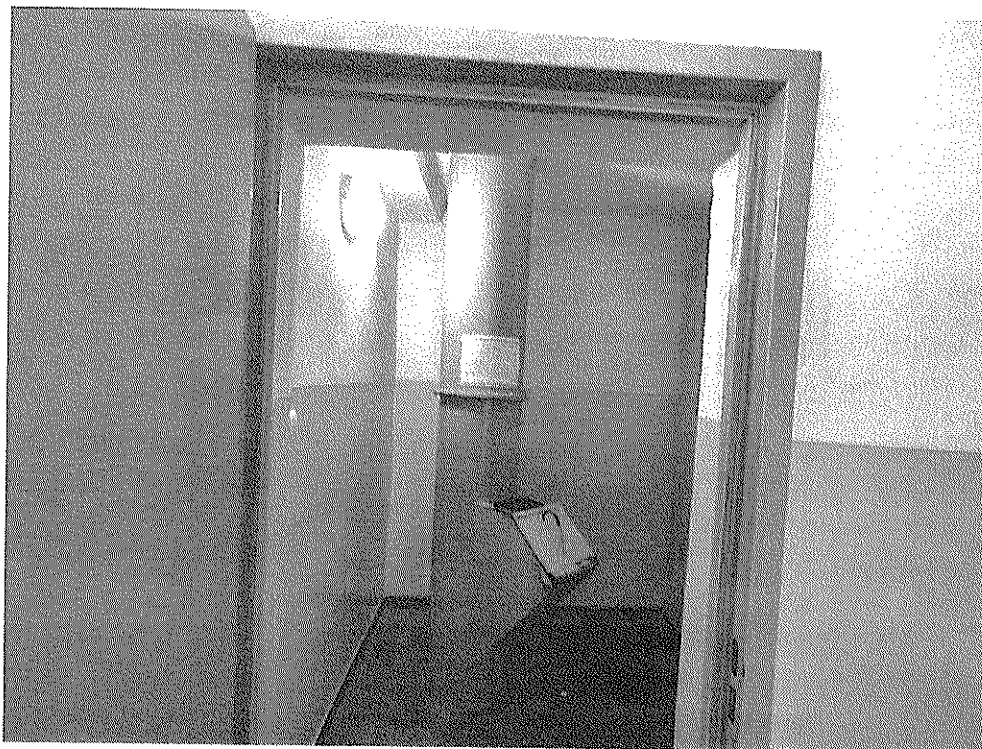
Pomieszczenie zsypu wraz z rurą zsypową
