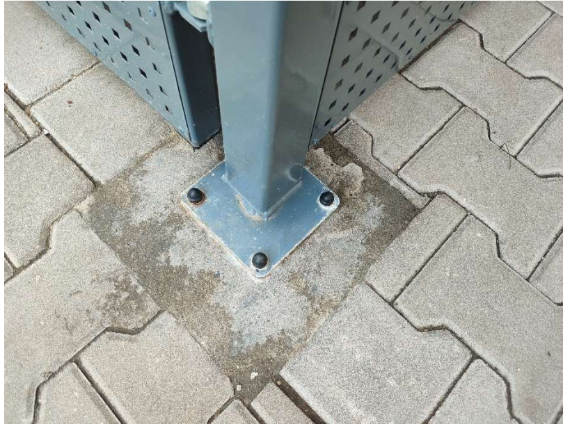
Mocowanie wiaty do prefabrykowanych fundamentów
