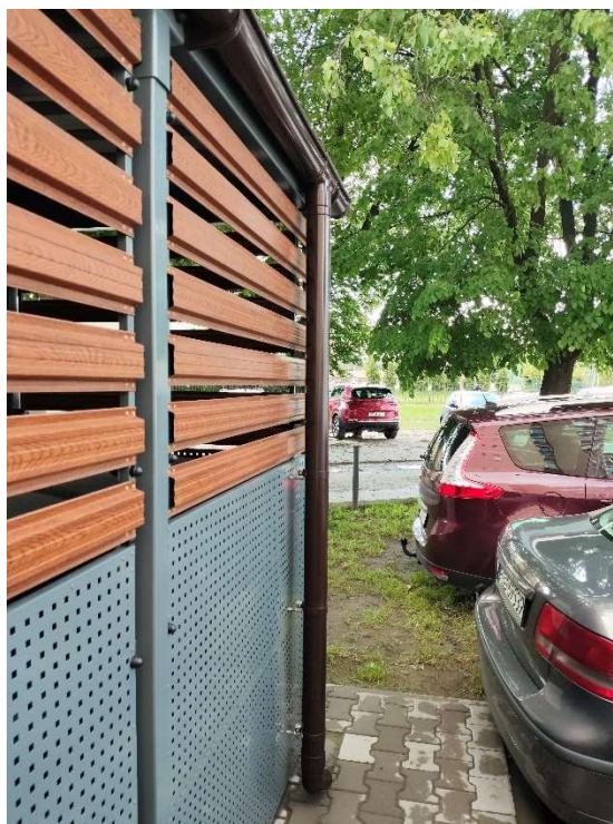
Wiatę wyposażyć w rynnę z PCV i rurę spustową
